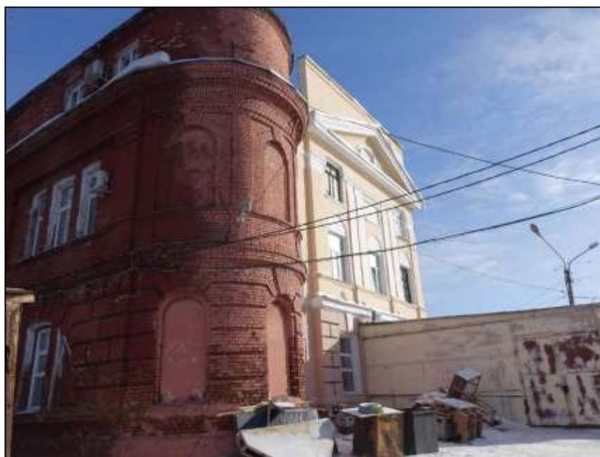
Фото 15. Объект культурного наследия «Общественное собрание», 1915 г. Вид со двора. Фото Комаровой Ю.Н., 13.02.2020 г.
