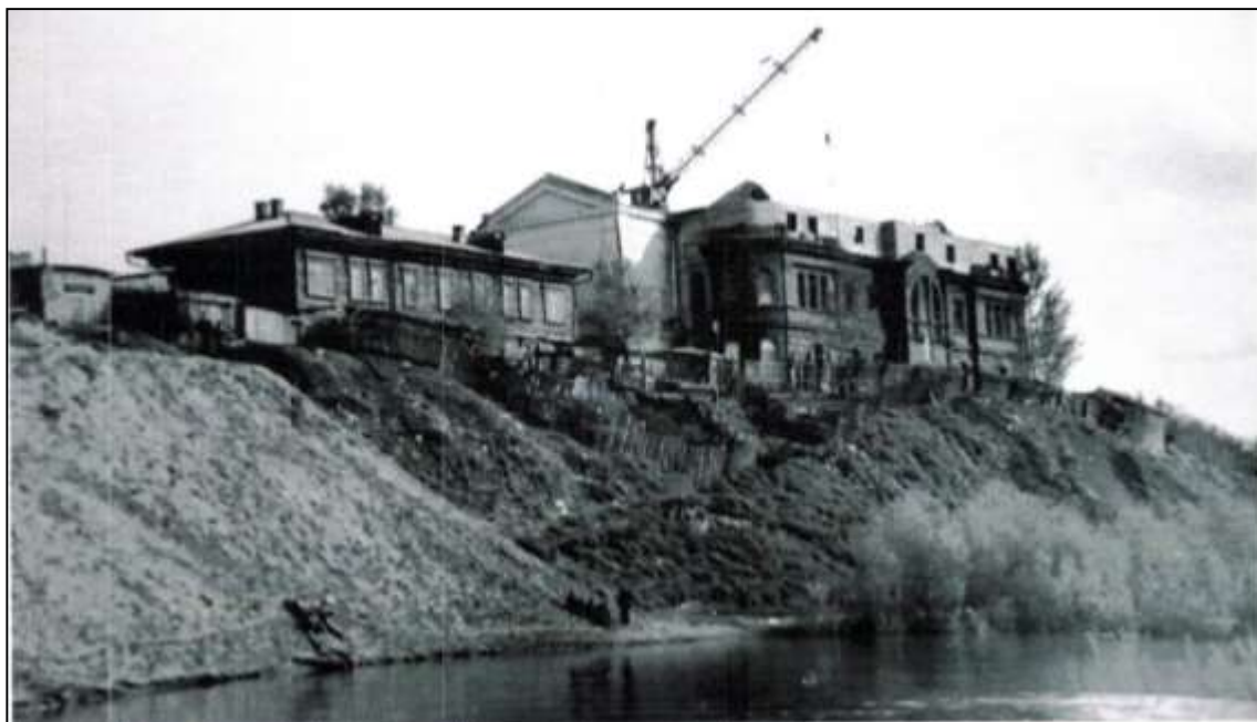
Фото 14. Реконструкция здания Ачинского городского театра. Надстройка третьего этажа, 1973 г. Из фондов Ачинского краеведческого музея
