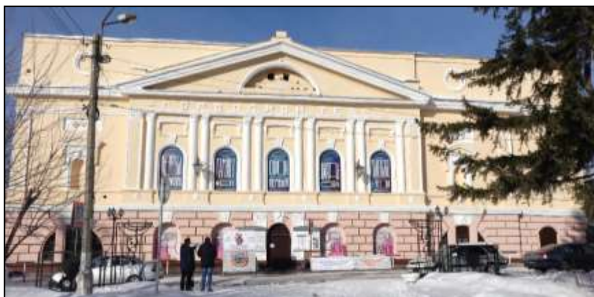
Фото 1. Объект культурного наследия «Общественное собрание», 1915 г. Главный фасад. Фото Комаровой Ю.Н., 13.02.2020 г.
