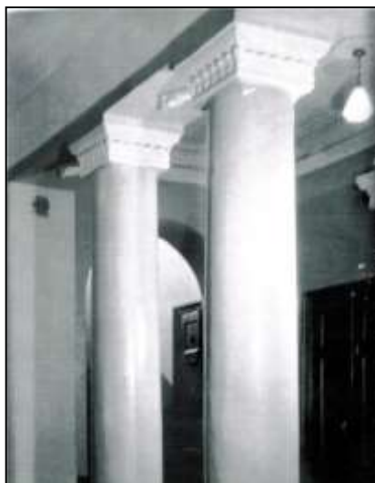
Фото 21. Ачинский городской театр. Фрагмент интерьера фойе первого этажа после капитального ремонта в 1954 г. Фото Ю. Бармина. Из фондов Ачинского краеведческого музея
