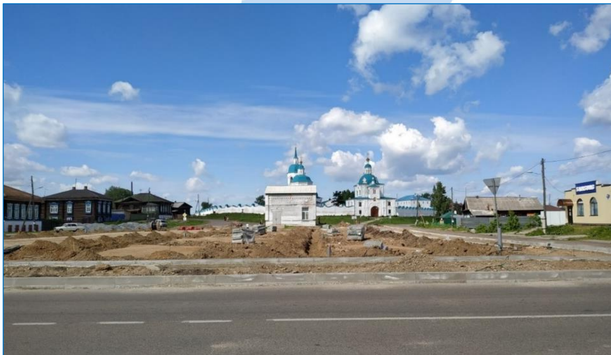
Проведение земляных работ (начальная стадия) по ул. Фефелова в г.Енисейске.
