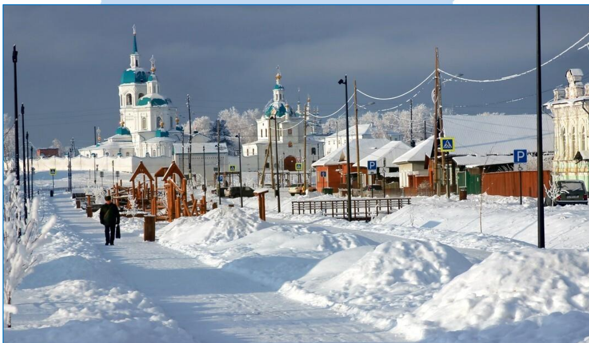
Окончательный вид после завершения благоустроительных работ по ул. Фефелова в г.Енисейске.
