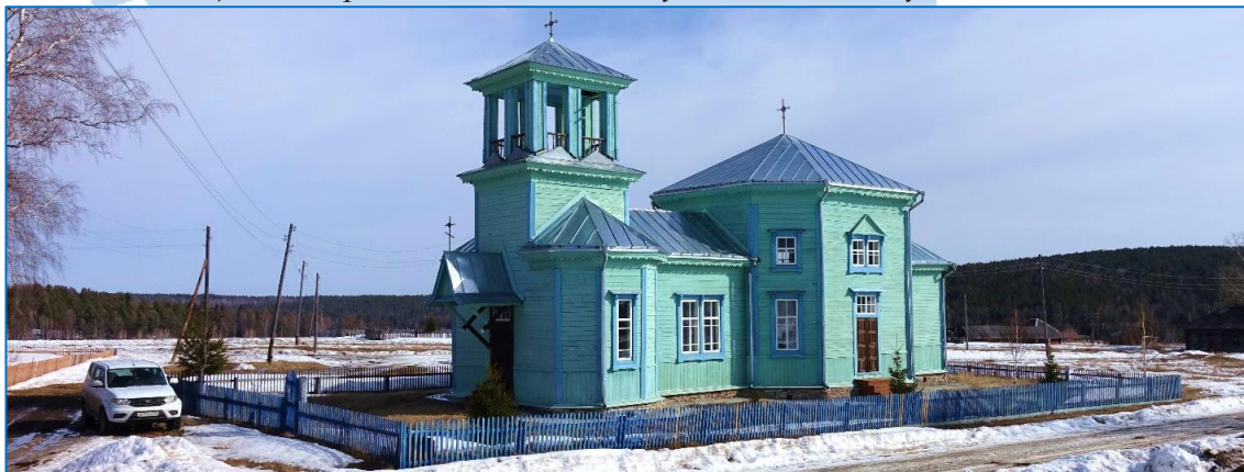
Общий вид церкви.
