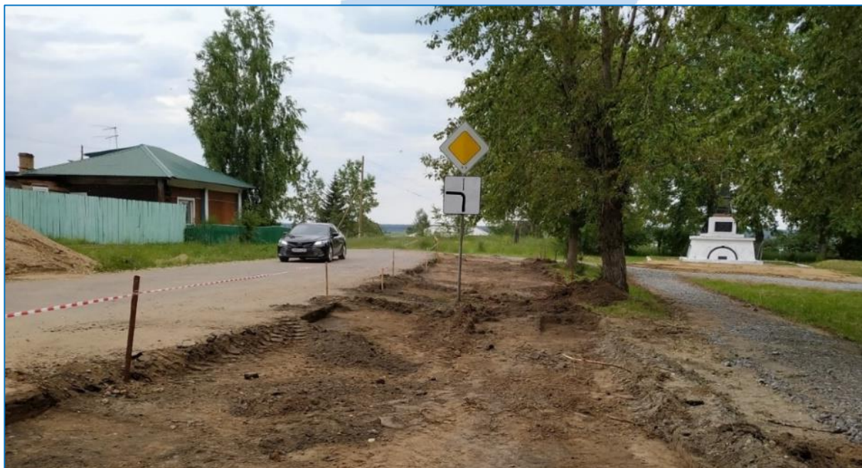
Проведение земляных работ (начальная стадия) в сквере по ул.Иоффе,1А в г.Енисейске.
