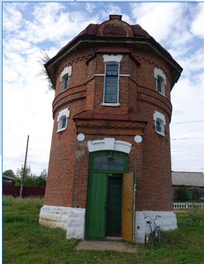
Объект культурного наследия регионального значения «Комплекс станционных построек», 1900-е гг.: водонапорная башня, расположенный по адресу: Красноярский край, Канский район, п. Бошняково,
