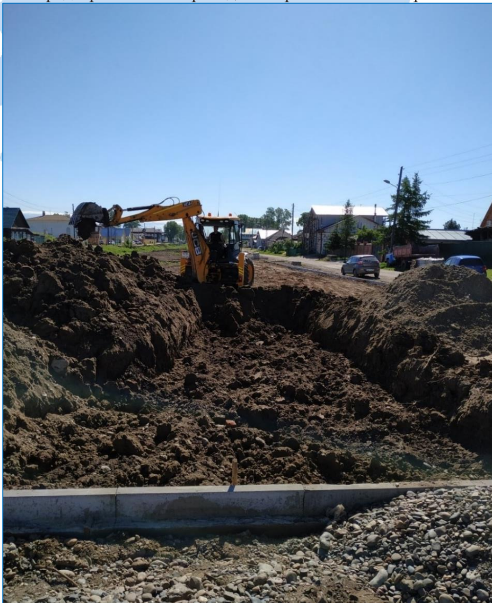
Проведение земляных работ механизированным способом без предварительного проведения археологических работ. Фрагмент траншеи возле ОКН регионального значения «Комплекс деревянных домов» по ул. Бабкина, 21 (ул. Фефелова, 99).
