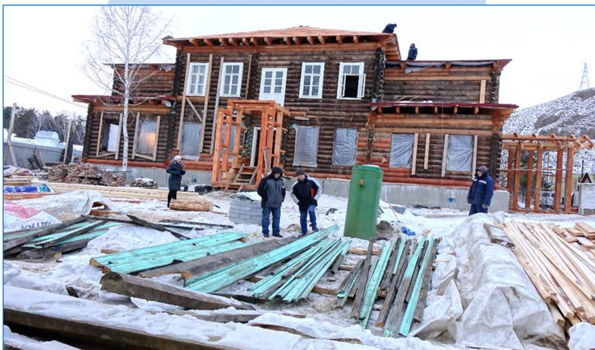
«Летний дом архиерея» в процессе ремонтно-реставрационных работ. Авторский надзор (продолжение 2019г.). Фото январь 2020г.
