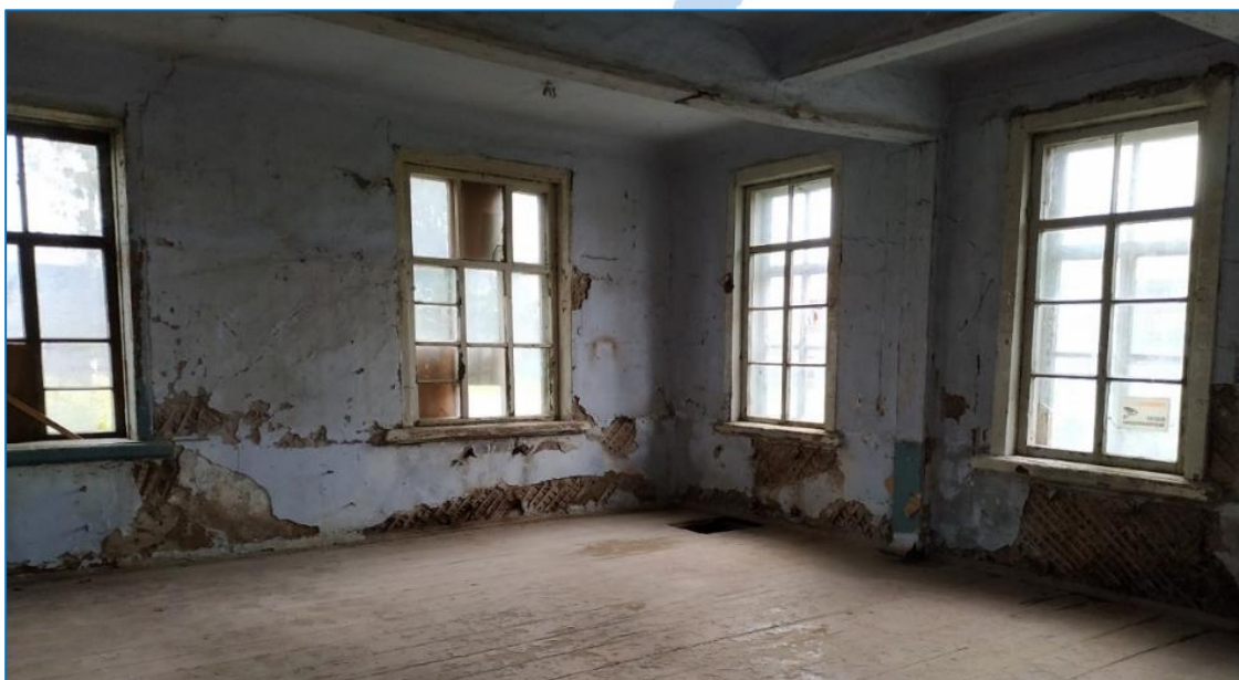
Фрагмент внутреннего интерьера выявленного ОКН регионального значения «Мужской барак комплекса Енисейской городской больницы» по ул. Декабристов, 1. Внутренние помещения очищены от мусора, застеклены рамы окон, заблокированы входные двери от проникновения посторонних лиц.
