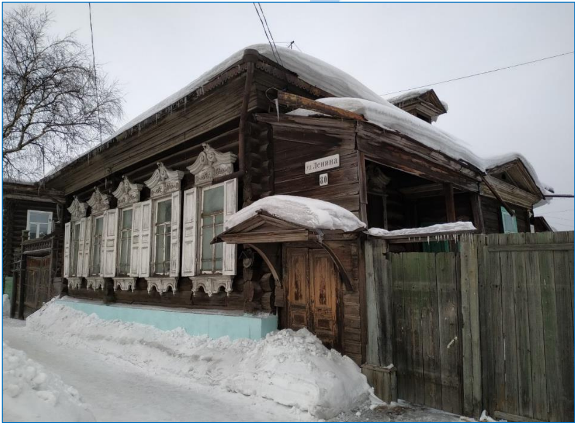
ОКН федерального значения «Комплекс жилых зданий (дер.)», кон. XIX в. по ул. Ленина, 80 в г. Енисейске
