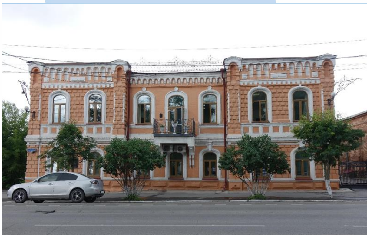
Объект культурного наследия регионального значения «Усадьба Максимова», кон. XIX – нач. XX вв.: дом жилой, расположенный по адресу: г. Ачинск, ул. Ленина, 24.
