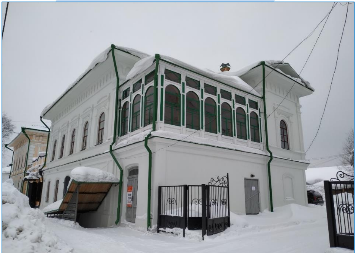
ОКН федерального значения «Усадьба Захарова, 1860–1870 гг.» по ул.Ленина, 97 в г. Енисейске.
