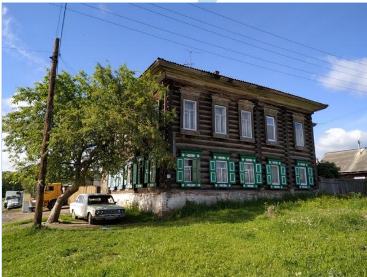
ОКН регионального значения «Дом жилой (дерево), сер. XIX в.» по ул. Бограда, 77 в г. Енисейске.
