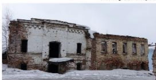
Северный фасад здания
