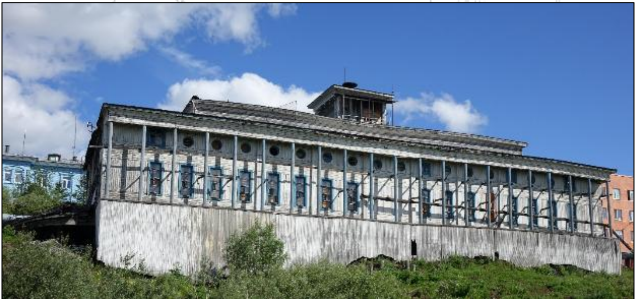
Здание речного вокзала Дудинского порта, построенное в 1949 г. Фото Гераськина М.Н. 11.07.2018.
