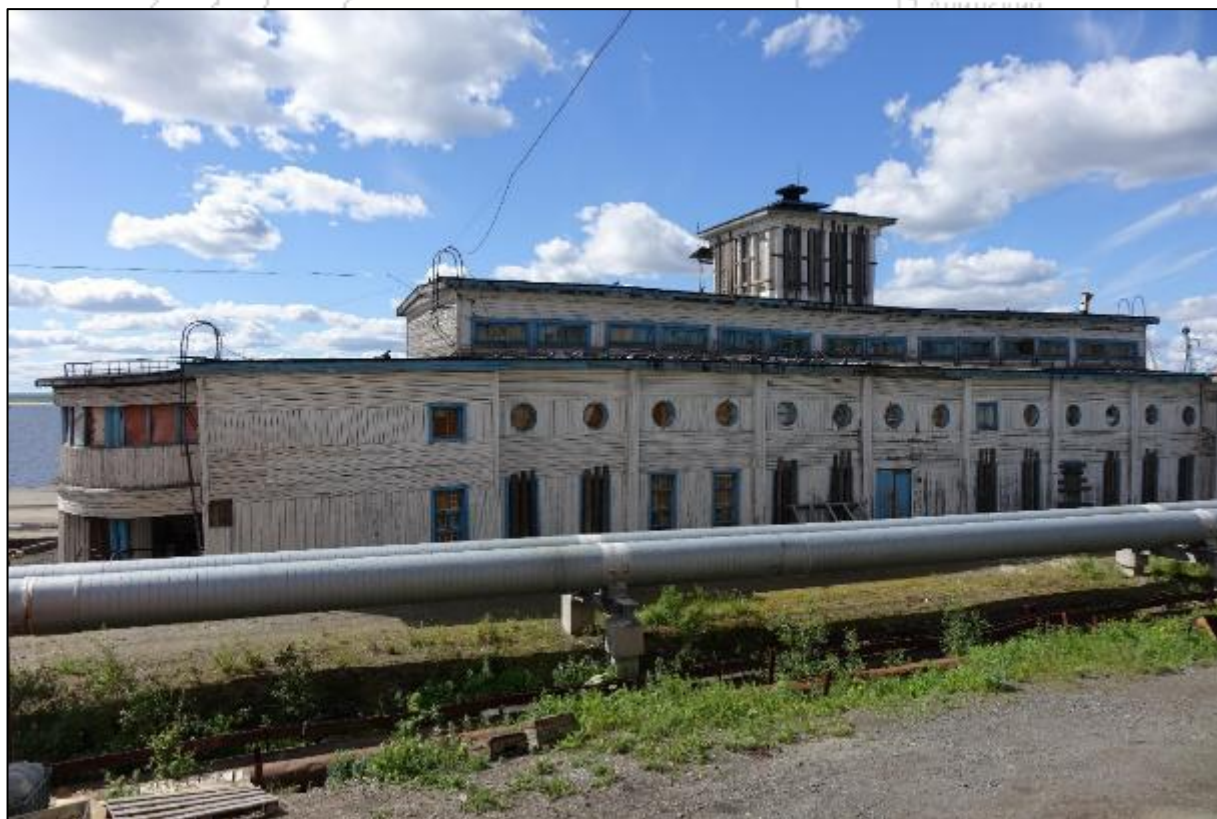
Здание речного вокзала Дудинского порта, построенное в 1949 г. Фото Гераськина М.Н. 11.07.2018.
