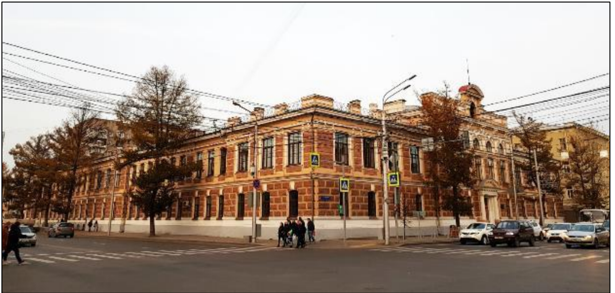
Здание «Мужской гимназии...» расположенное по адресу: г. Красноярск, ул. Ленина, 70/ ул. Вейнбаума, 36. Фото Григорян Н.С., 19.10.2018.
