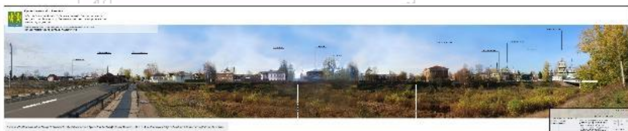
Композиция и силуэт застройки исторического поселения. Вид застройки левого берега р. Мельничная
