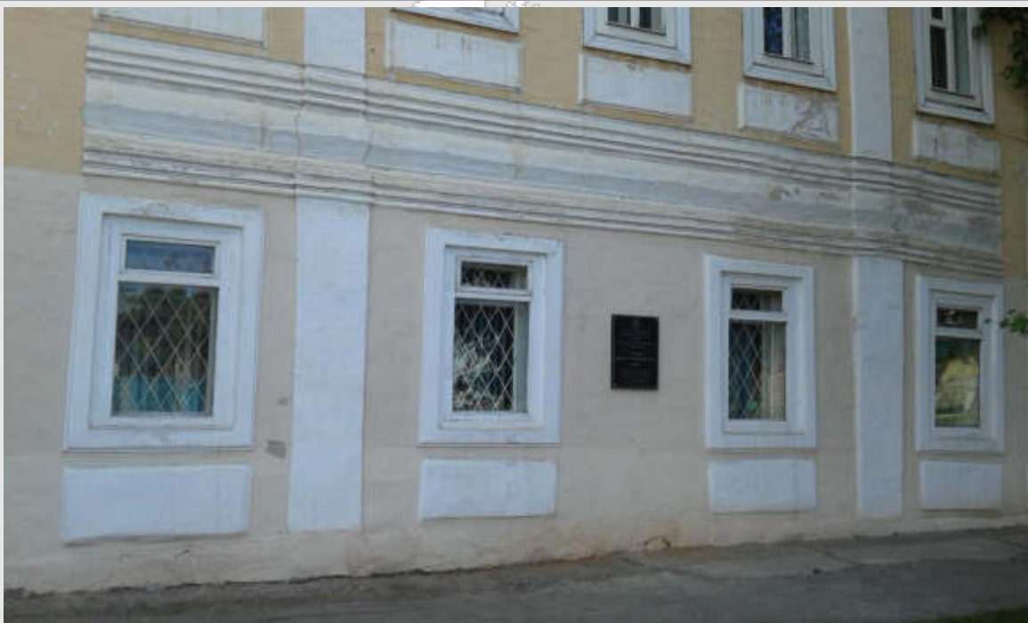
Фрагмент фасада ОКН «Здание присутственных мест» с установленной информационной надписью
