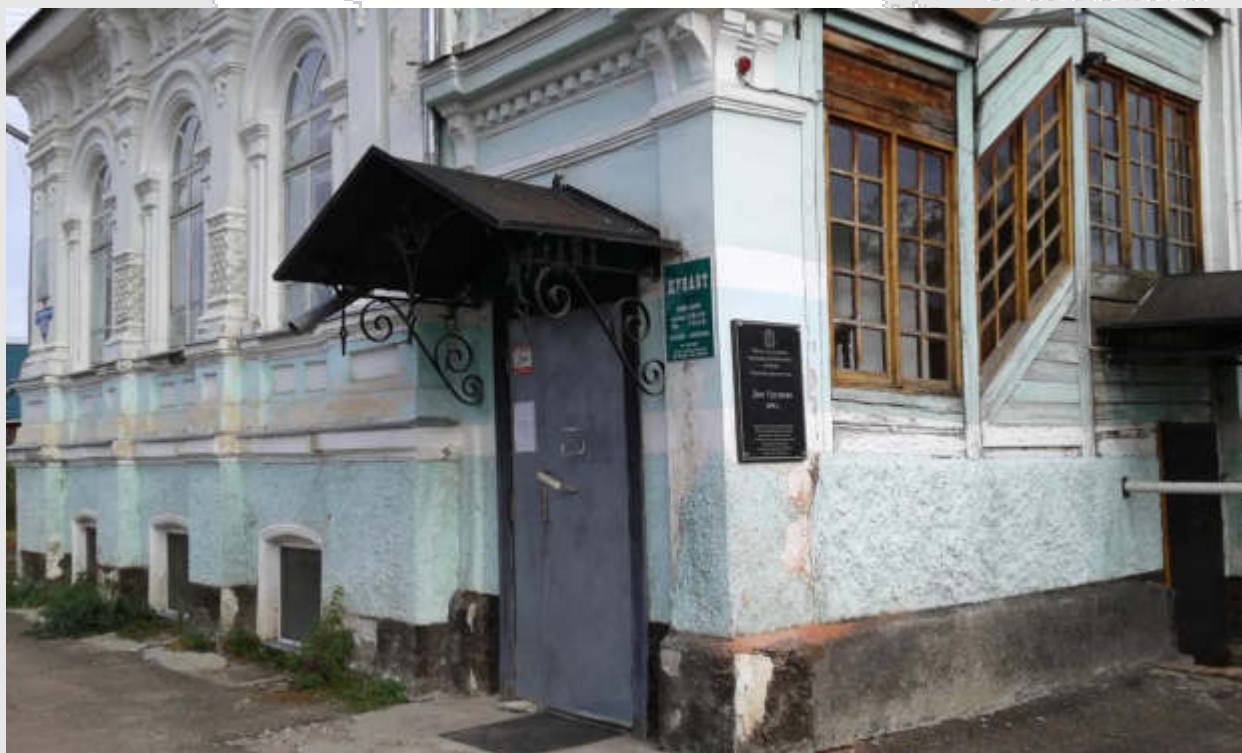
Фрагмент фасада ОКН «Дом Урушева, 1890г.» с установленной информационной надписью
