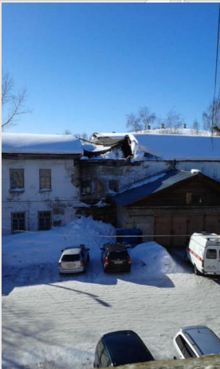
Обрушение кровли и стропильной системы на ОКН «Усадьба Кытманова» по ул.Кирова, 82 в г.Енисейске по причине ненадлежащего использования объекта арендатором Енисейская ЦРБ.
