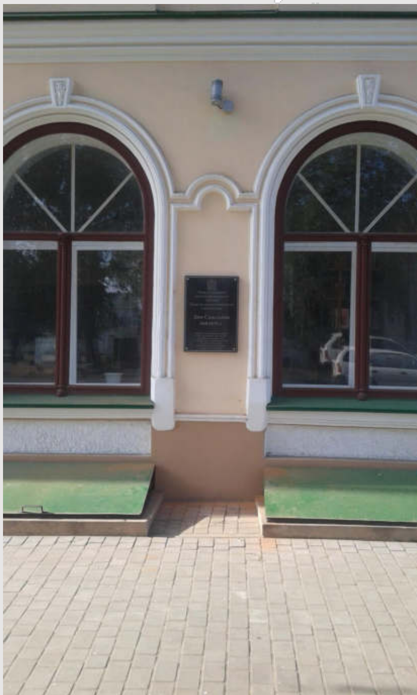
Фрагмент фасада ОКН «Дом Савельева»
