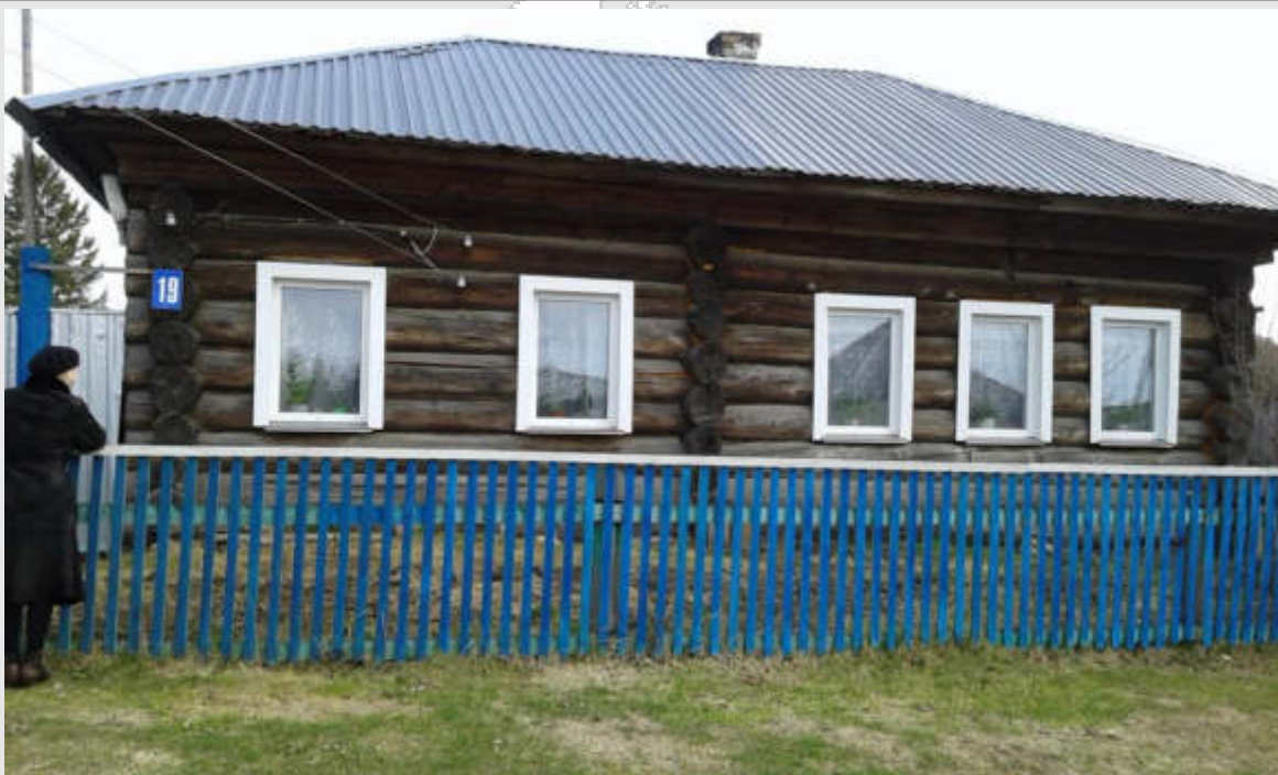
Объект культурного наследия регионального значения «Усадьба М.Ф. Дуракова, кон.Х1Х в.» в с.Плотбище, Енисейского района
