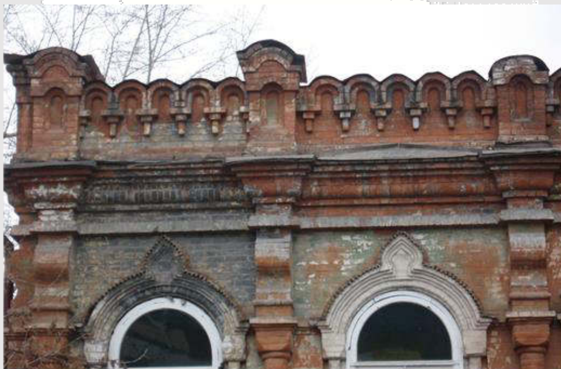
Фрагмент северо-восточного фасада: кирпичный декор парапета, карниза, капителей пилястр. Фото апрель 2017 г.
