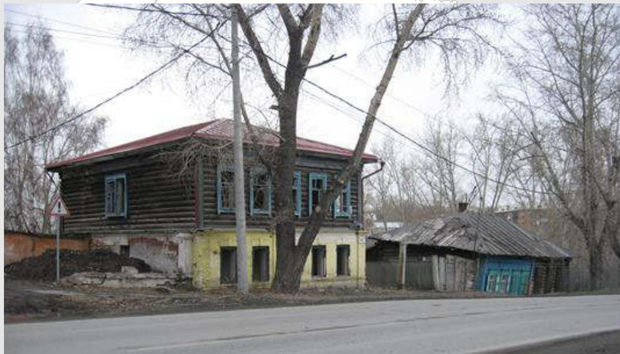
Общий вид здания с южной стороны. Фото апрель 2017 г. (до пожара)
