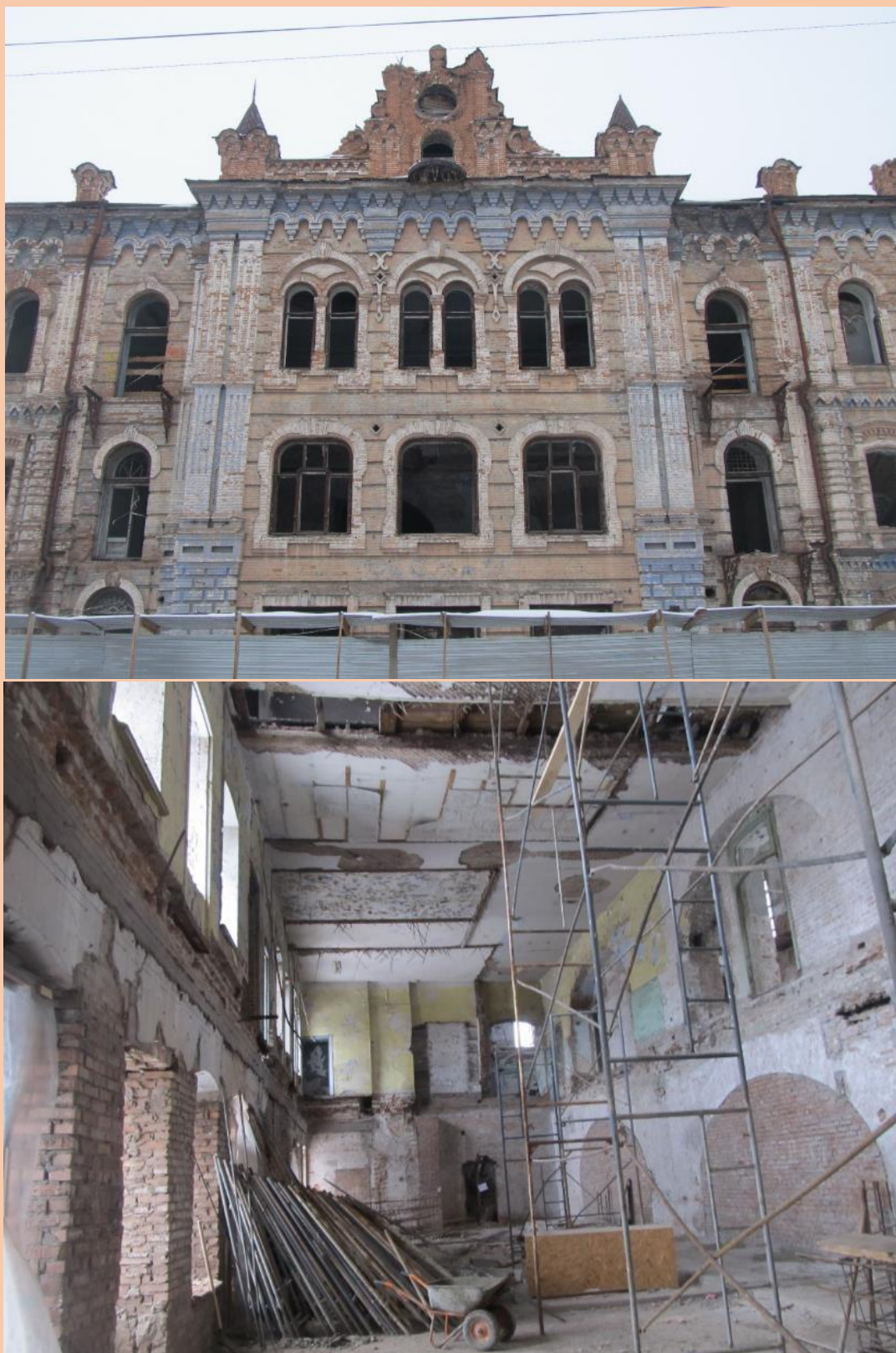
Технический осмотр. г. Канск «Собор Спасский», 1804 г., 1912 г.
